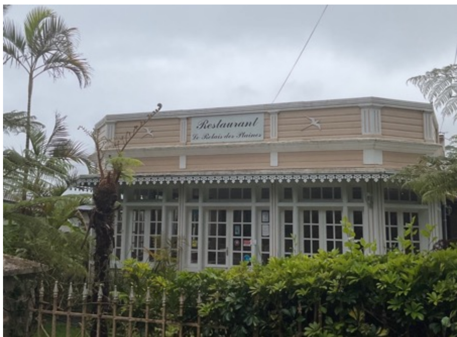
Enseigne parallèle au mur de qualité intégrée au bâti
