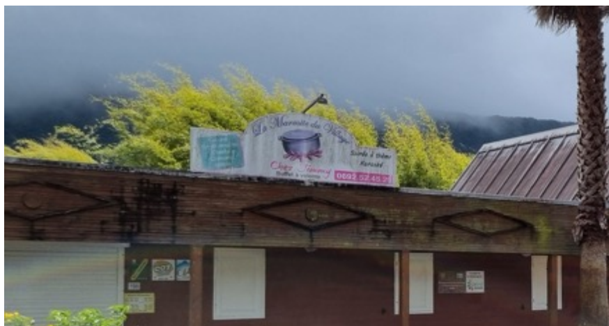
Enseigne sur toiture avec un panneau plein (illégal)
