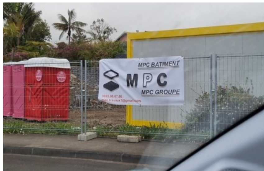
Enseigne temporaire sur une clôture pour des travaux
